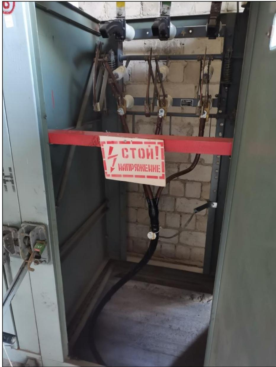
При комиссионном осмотре ячейки № 2 РУ-10 кВ ТП № 29 наблюдалось разрушение изолятора фазы А ВН-16, вследствие чего, со слов начальника ЭУ, фаза А ВН-16 полностью не вышла, дугогасительный нож остался в камере и под напряжением 10 кВ.
