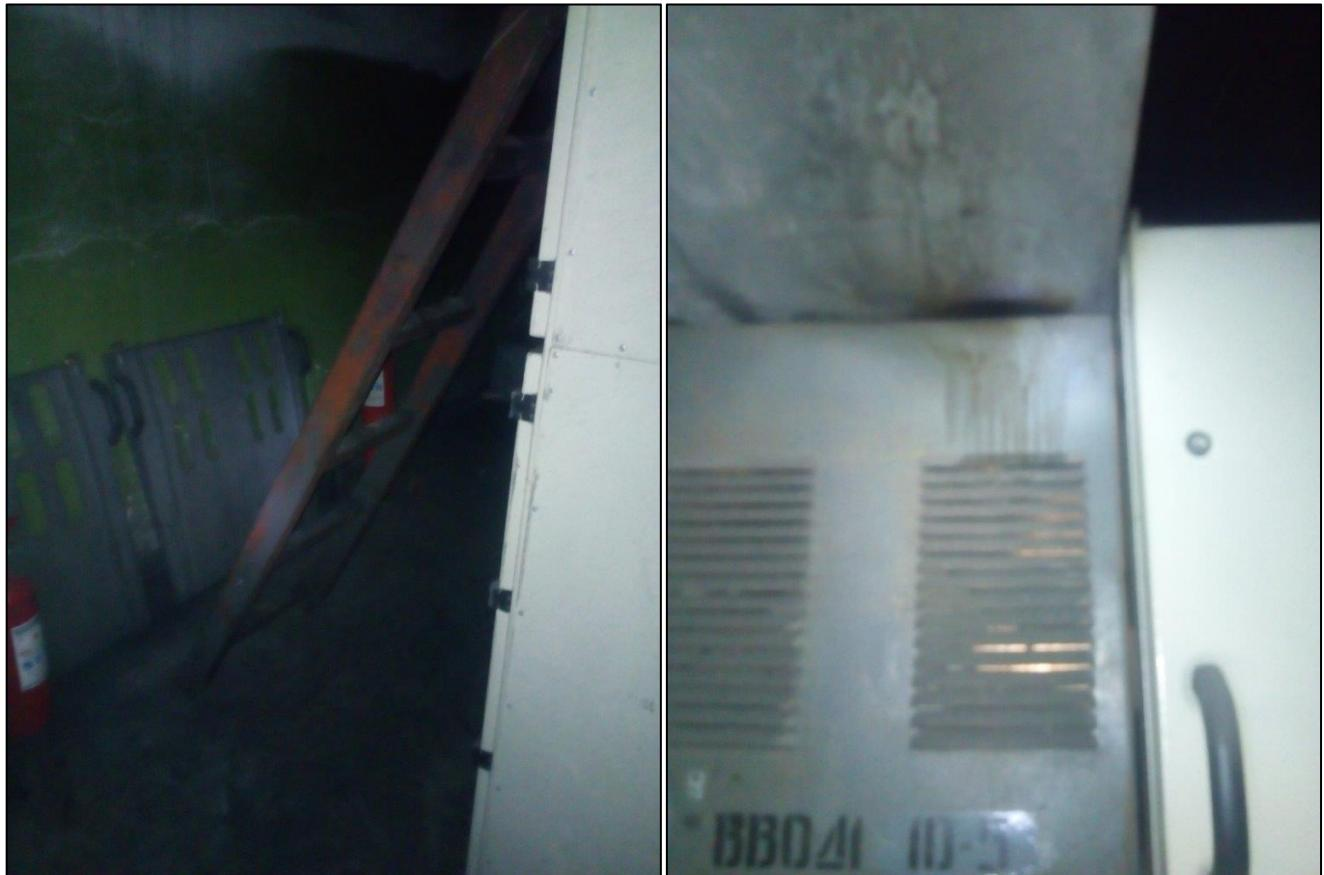
В 20:18 по согласованию со старшим мастером ОДС был отключён высоковольтный выключатель (ВВ) ячейки 110-4 (Т-2) ГПП-3, обесточив секции № 2 и № 4 10 кВ, вызван пожарный караул АО «ЧЭМК» и скорая помощь.
