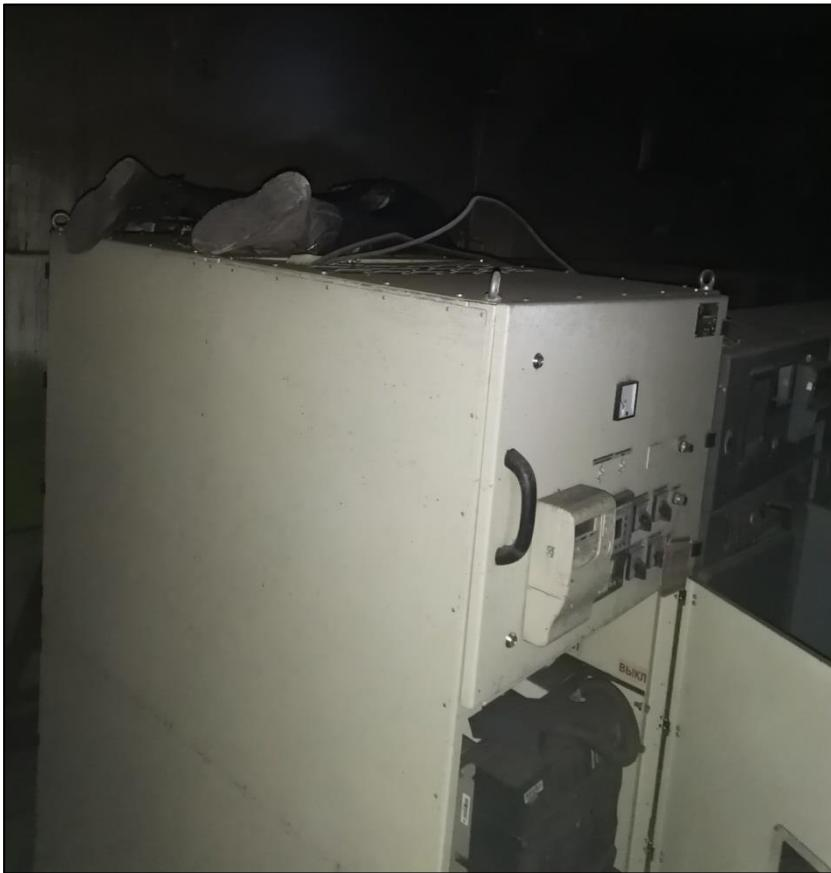
В 21:48 после проведения необходимых отключений и проведения организационно-технических мероприятий, проверки отсутствия напряжения и заземления сборных шин 10 кВ 1-ой секции персонал пожарного караула совместно с персоналом ЦСП поднялся по приставленной лестнице для снятия тела заместителя начальника цеха. В момент
